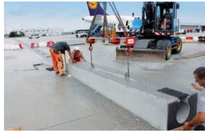
Die am Flughafen „Franz Josef Strauß“ verwendeten BIRCOport-Bauteile wurden den Prüfungsergebnissen entsprechend modifiziert, sodass das Rinnensystem problemlos und exakt in die vorhandene Fläche integriert werden konnte.
