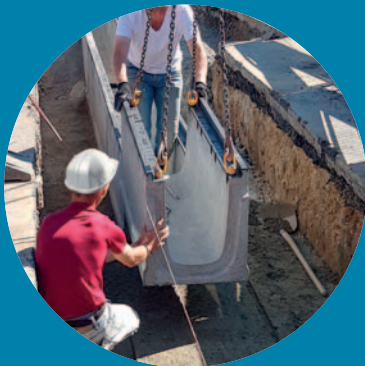
Verlegung der BIRCOmax-i® Bauelemente
