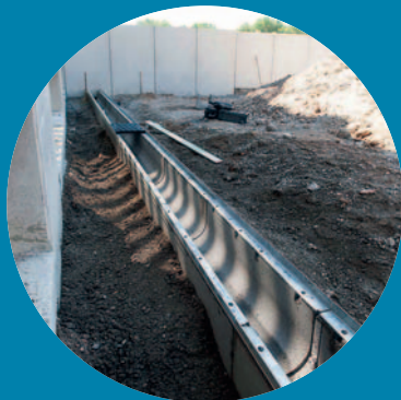
BIRCOsir NW100 / NW200 AS für die optimale und sichere Entwässerung des Containerterminal II
