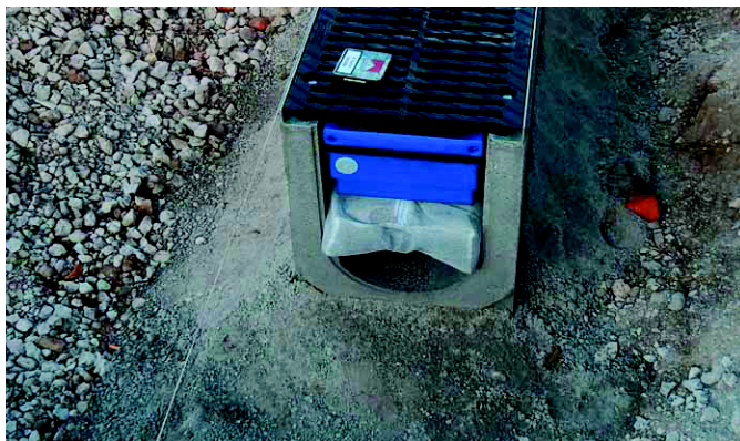
Fundament und Einbau nach Klasse D400
