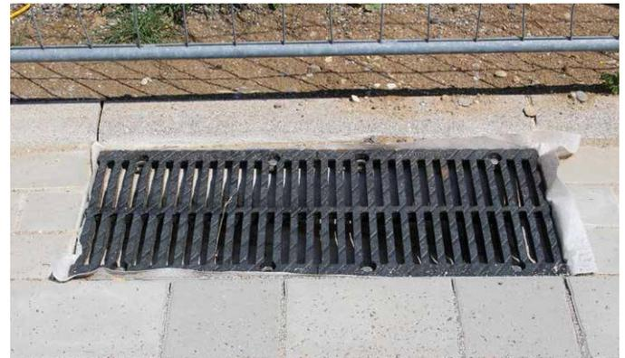
Schutz der Filter durch Geotextil in der Bauphase
