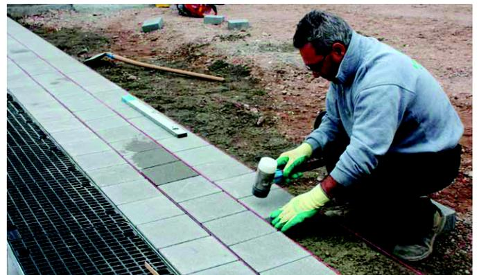
Drei Reihen Plaster in Betonfundament
