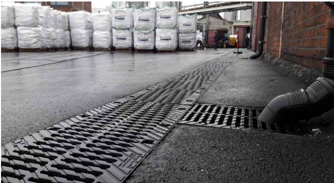
Vorreinigung von Dachabflüssen durch Absetzelement in Rinnenform.
