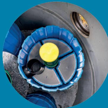
BIRCOhydropoint® 1000 - im Aufstromverfahren werden Schadstoffe adsorptiv gebunden
