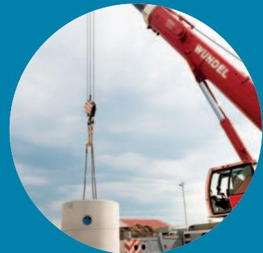
Der monolithische Baukörper wird vom Schwerlast-Lkw direkt in die Baugrube abgesenkt.
