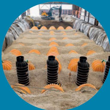
BIRCO Rigolentunnel von StormTech® mit einem Speichervolumen von 3,01 m<sup>3</sup> / Element
