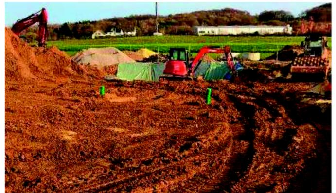
Auffüllung und Entlüftungsrohre (KG2000)
