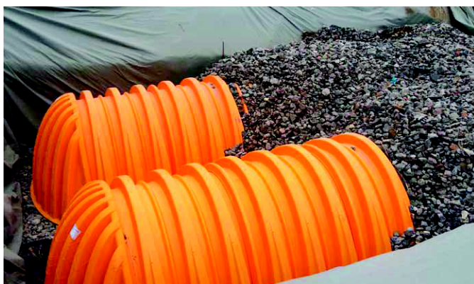
Auffüllen der Anlage mit Schotter
