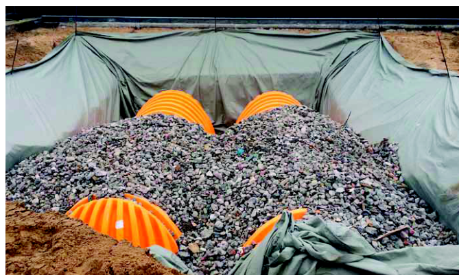
Einfassung mit Geotextil
