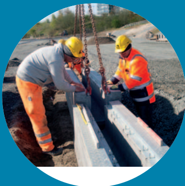
Verlegung der BIRCOMassiv-Baukörper
