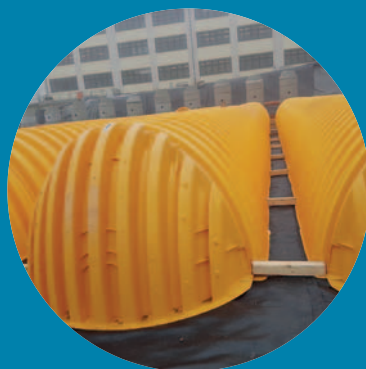
Das Retentionssystem ist mit PEHD-Folien ausgelegt, die miteinander verschweißt sind.
