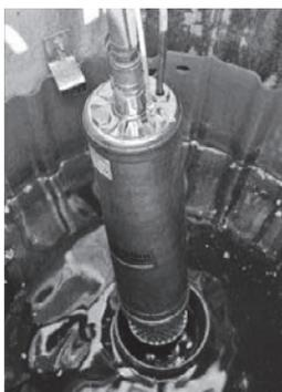
1. Schlammpumpe über das Absaugrohr in den Schacht herablassen
