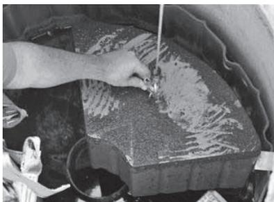
1. Seilzug in Filteröse einhaken und Filter ganz aus dem Schacht herausziehen
