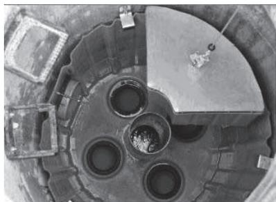
1. Filter mit Winde in den Schacht herablassen und in die Dichtungen stecken
