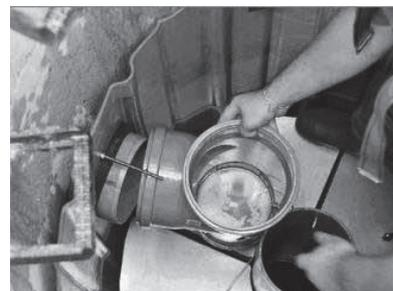
3. T-Stück einsetzen, wenn alle vier Filter eingebaut sind
