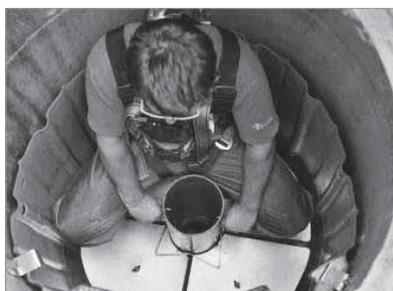
5. Aufstromsicherung wieder aufstecken und einrasten
