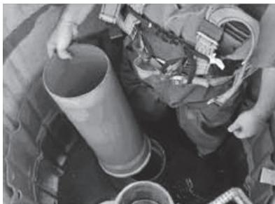
1. Überlaufrohr aus der Muffe ziehen und aus dem Schacht herausheben
