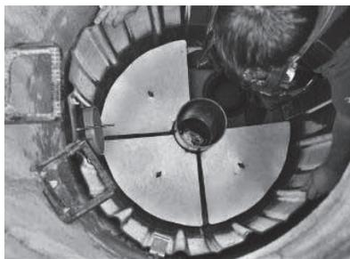
2. Mit den beiden Filtern unter dem Ablauf beginnen, dann die anderen befestigen
