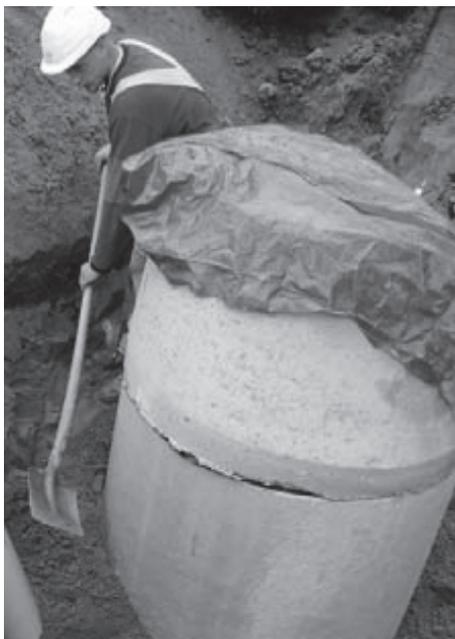
1. Es dürfen keine Verschmutzungen oberhalb der Filter stattfinden. Filterelemente abdecken oder entfernen. Schmutzwasser nach Anschluss des Filterschachtes an das anschließende System nicht einleiten, sondern fachgerecht entsorgen (Schacht auspumpen).
