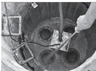
5. Dichtungen für die Filterelemente gründlich spülen
