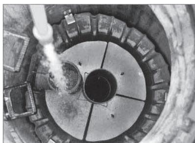
1. Wasser in den Ringraum zwischen Filtern und Schachtwand fließen lassen
