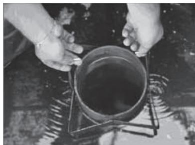
5. Aufstromsicherung nach oben weg-ziehen und aus dem Schacht heben
