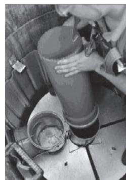
6. Überlaufrohr auf das mittlere Rohr stecken
