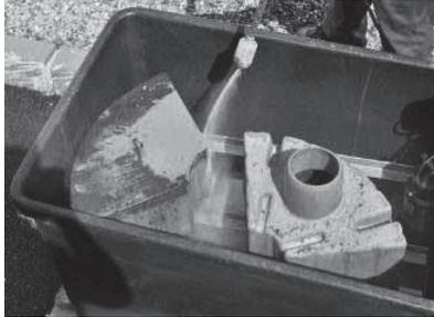
1. Bei kleiner Wartung Filterelemente von außen spülen, sonst neue einbauen
