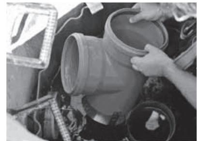
3. T-Stück komplett herausnehmen und aus dem Schacht herausheben
