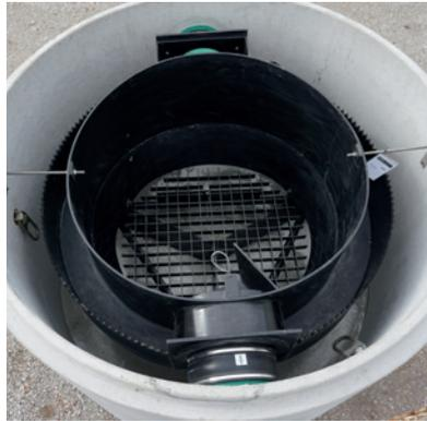
11. Fixieren Sie den BIRCOhydroshark durch Verkontern der beiden mitgelieferten Muttern an den Fixierankern und achten Sie darauf, dass die Abstände der Schachtwandung und des Zackenwehres gleichmäßig auf beiden Seiten sind.
