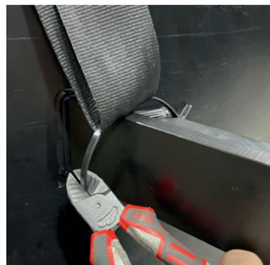
3. Lösen Sie die am BIRCOhydroshark fixierte Gurtschleife und verwenden Sie nur diese zum Anheben bzw. Einsetzen in den Schacht. Nach Fertigstellung der Montage entfernen Sie die Gurtschlaufen von der Anlage.
