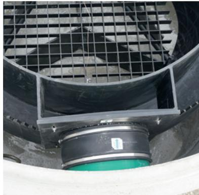
8. Anschließend stellen Sie die Rohrverbindungen her. Achten Sie darauf, dass die Dichtungen mit ausreichend Schmiermittel (nicht ölhaltig) bestrichen sind. Schieben Sie zum Anschließén die Rohre von außen durch die Dichtungen der Schachtwandung und verbinden Sie nun das Rohr mit dem Flansch am BIRCOhydroshark mittels der Dichtmanschette.
