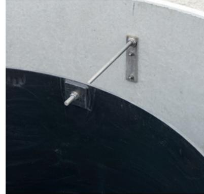
4. Setzen Sie den BIRCOhydroshark so in den Schacht ein, dass der Zu- und Ablauf bereits in die richtige Richtung weisen.
