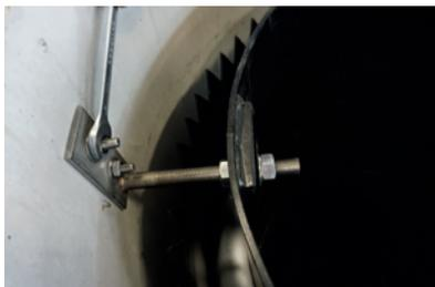
10. Setzen Sie nun die Fixierungsanker durch die Wandung des BIRCOhydrosharks ein und befestigen diese mittels der mitgelieferten Dübel und Bolzen an der Schachtwandung
