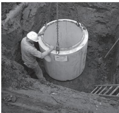
2. Schacht setzen und waagerechte Lage kontrollieren. Zulauföffnung in die korrekte Position ausrichten.
