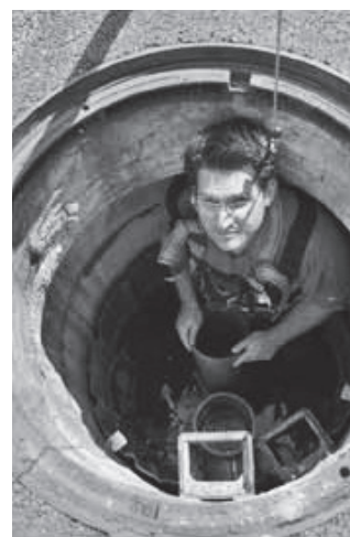
6. In den Schacht hineinsteigen und auf Filterelemente stellen
