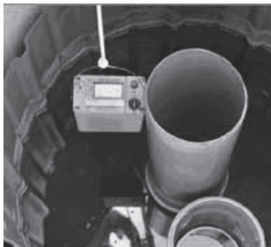
2. Mit Gaswarngerät Atmosphäre im Schacht prüfen und ständig überwachen
