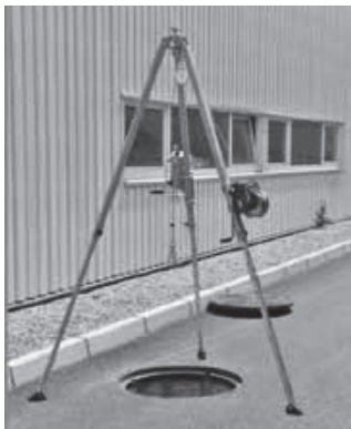
1. Rettungs-Dreibein über dem geöffneten Schacht
