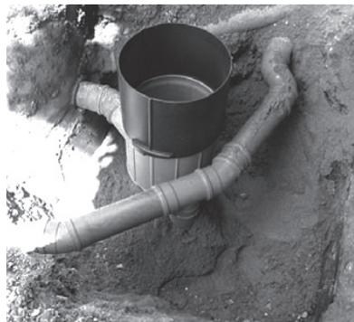
5. Nachdem alle Verbindungen geprüft worden sind, werden das Filtergehäuse und die Leitungen eingesandet. Die Leitungen sind dabei gut zu unterstopfen, damit sie beim Verfüllen der Baugrube nicht beschädigt werden.
