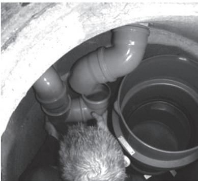
4. Filtergehäuse auf die Halterung stellen. Rohre mit entsprechenden Bögen anschließen. **Tipp:** Zum Zuschneiden die Dichtungen aus den Muffen nehmen, so lassen sich die Rohre leichter stecken. Wenn alles passt, Dichtungen einsetzen und mit Schmiermittel die Rohre zusammenstecken.
