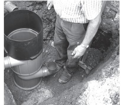
3. Zulauf Regenwasser anbringen. Am günstigsten ist es, den Absturz vor dem Filter zu montieren. Dazu 87°-Bogen am unteren Anschluss anbringen und die Regenwasserleitung / Regenwasserleitungen anschließen.
