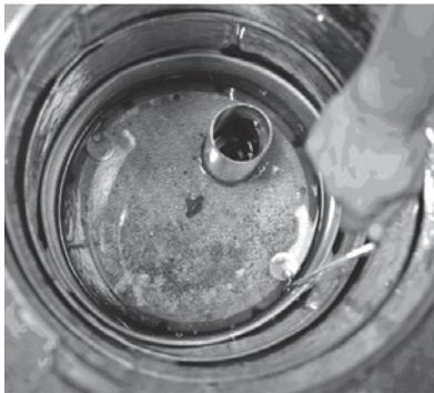
4. Die zweite Auftriebssicherung nach innen drehen.
