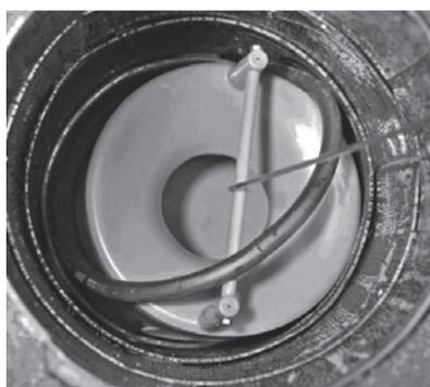
1. Schlammemeimer und Dichtung mit dem Werkzeug wieder einsetzen.
