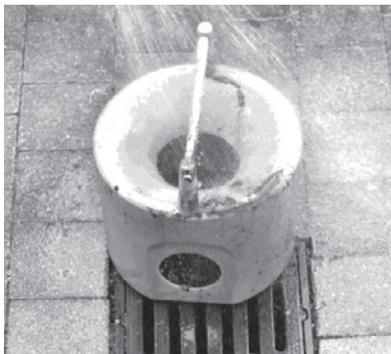
4. Schlammwasserteimer von außen mit Wasserstrahl reinigen.
