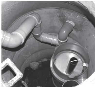
5. Rohre und alle Verbindungen überprüfen (Dichtungen alle vorhanden, sauberer Sitz). Rohre mit Rohrschellen arretieren, um bei einer späteren Wartung genügend Halt bei der Entnahme des Filtereinsatzes zu haben. Evtl. Rohre mit kleinen Edelstahlschrauben gegen Verdrehen sichern.
