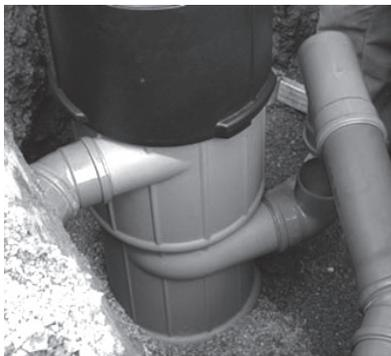
4. Optimal wäre eine Höhendifferenz von 680 mm zwischen den ankommenden Regenrohren und dem unteren Zulauf in den Filter. Hier in unserem Beispiel nimmt man einen kurzfristigen Rückstau in das bestehende Leitungssystem in Kauf. Auf Dichtheit der Anschlüsse und der erdverlegten Leitungen ist zu achten.
