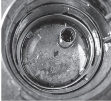
2. Blick auf den Filter, die Auftriebssicherungen sind festgestellt und die Überlaufklappe ist fest montiert.
