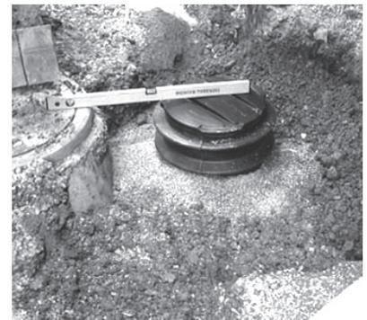
6. Die Teleskopverlängerung mit Deckel an dem gewünschten Niveau mit Hilfe einer Wasserwaage ausrichten und die Kragen der Teleskopverlängerung mit Sand oder feinem Splitt unterfüllen. So liegt der Druck nicht auf dem BIRCOhydropoint® und auf den Rohren.
