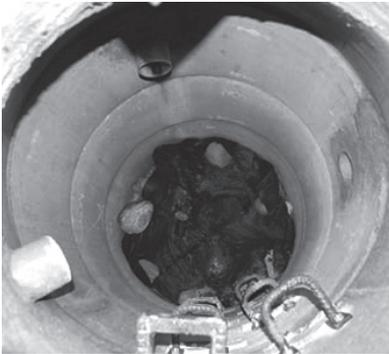
1. Schacht für den Einbau vorbereiten. Zulaufleitungen kontrollieren. Genügend Bögen und Leitungen für den Anschluss bereithalten.
