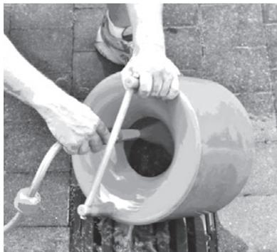
5. Schlammwasserteimer von innen mit Wasserstrahl reinigen.
