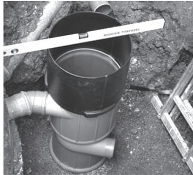
2. Filter an den Zulauf des Speichers anschließen, waagerechte Lage kontrollieren.
