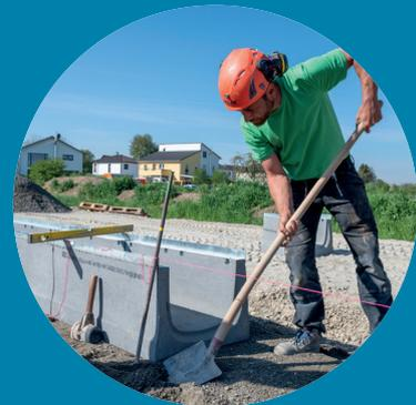
Hoher Abflussquerschnitt bei geringer Einbautiefe
