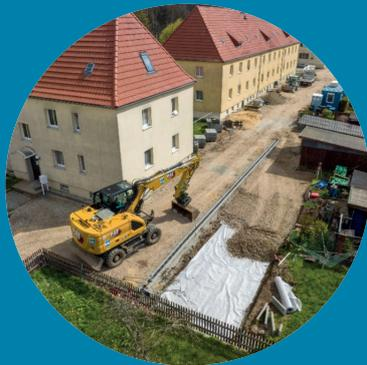
110 Meter BIRCOslim® für eine effiziente Oberflächenentwässerung.
