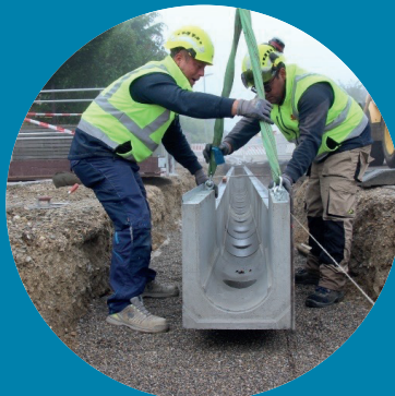
Auf Kiesrigolen wurden 151 Meter der BIRCOpur® verlegt
