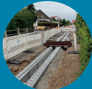
Oberflächennahe und verkehrssichere Linienentwässerung
