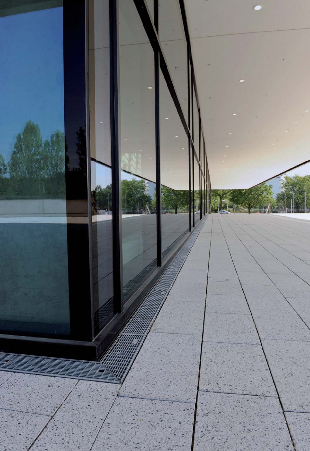
BIRCOLight® Fassadenentwässerung an einem Geschäftshaus in Bayern
