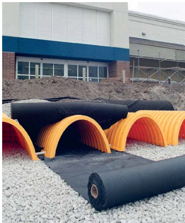
Abbildung 13: Bändchengewebe unter Isolator Row und Umhüllung mit Vliesstoff bei SC-310 & SC-800
