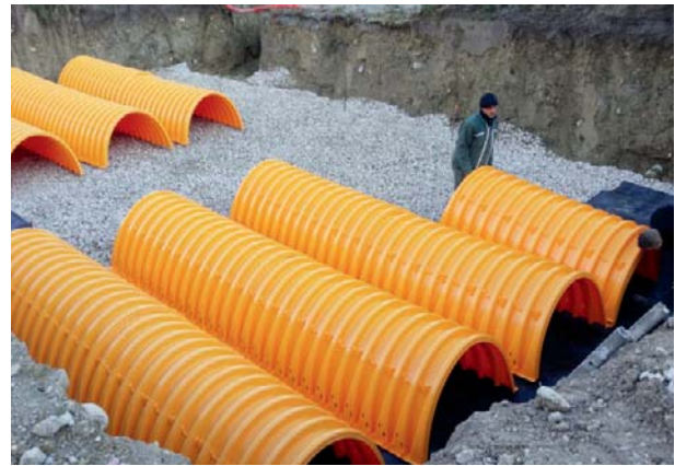
Abbildung 12: Bändchengewebe unter Isolator Row und den Einlassen der benachbarten Tunnelreihen
