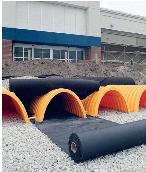
Abbildung 13: Bändchengewebe unter Isolator Row und Umhüllung mit Vliesstoff bei SC-310 & SC-800
