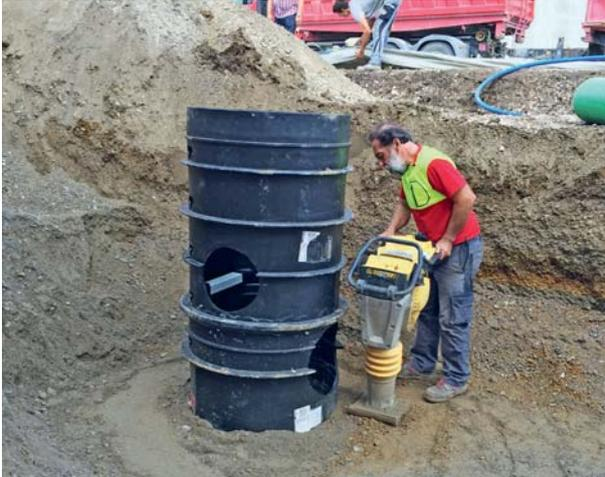
Es ist mindestens ein Verdichtungsgrad von  $D_{pr} = 97\%$  entsprechend DWA-A 139, Abschnitt 11.1 auf die gesamte Schachttiefe nachzuweisen. Im Straßenunterbau ist auf dem Planum ein Verformungsmodul  $E_{V2}$  von mindestens  $100 \text{ MN/m}^2$  nach ZTVE-StB 94 zur Auflagerung der Abdeckung Kl. D 400 erforderlich (vgl. Abschnitt „Einbau Abdeckung“).
