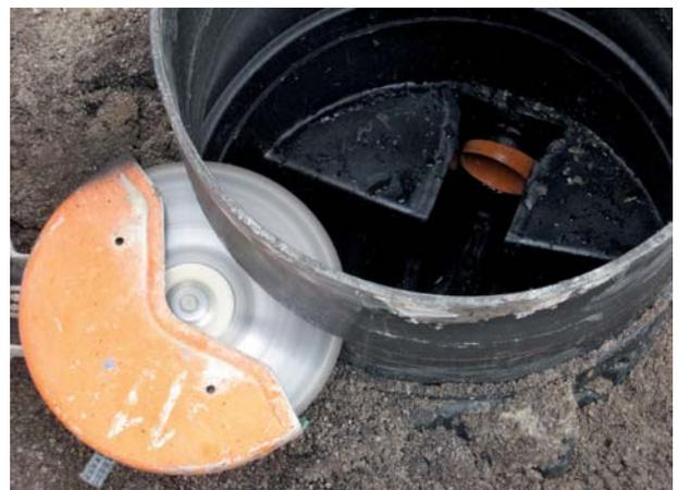
Das Anpassen der Bauhöhe erfolgt durch Einkürzen des Konushalses. Das Kürzmaß beträgt bei BIRCO Systemschächten maximal 25 cm. Das Einkürzen erfolgt mittels einer Säge (elektrische Stichsäge oder Fuchsschwanz) durch Abschneiden des Schachthalses entlang der horizontalen eingepprägten Linien. Die entstehende Schnittfläche ist zu entgraten.
