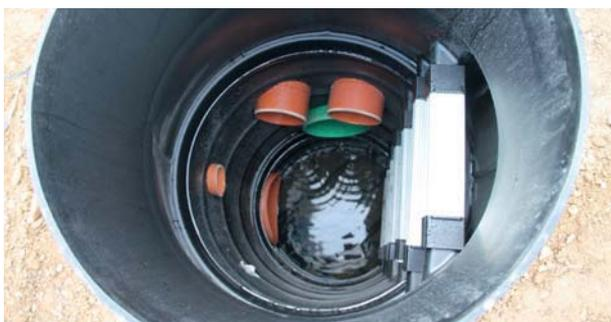
Die Schachtbauteile werden bis zum „Anschlag“ mittels Körpergewicht bzw. geringer Auflast miteinander verbunden.
