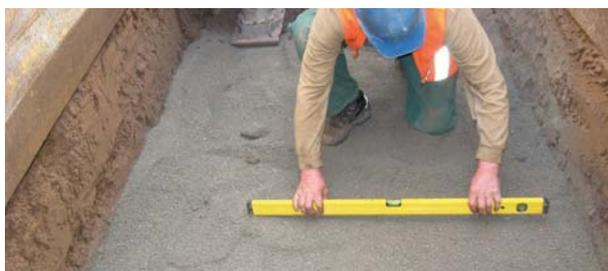
Die mindestens erforderliche Schichtdicke unterhalb der Schachtsohle beträgt 10 cm. Die Dicke der unteren Bettungsschicht (Sauberkeitsschicht) ist nach DIN EN 1610, Abschnitt 7.2 als „Bettung Typ 1“ auszuführen. Der Auflagerbereich des Schachtbodens ist tragfähig auszuführen und eben und vollflächig abzuziehen. Der Auflagerbereich des Schachtbodens ist gemäß den Planungsvorgaben herzustellen.
