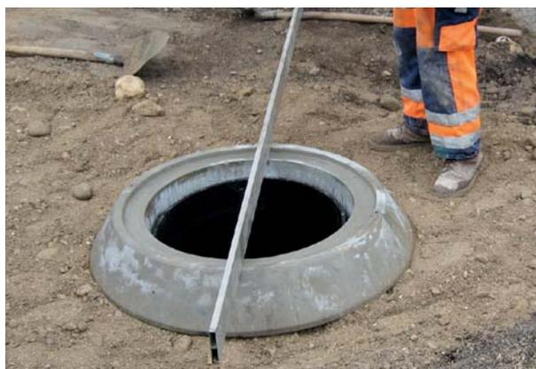
Bei Bedarf ist ein Betonauflagerung mit integrierter Keildichtung zu verwenden. Die Dichtung mit ausreichend Gleitmittel einstreichen und anschließend den Betonauflagerung zentrisch aufsetzen ohne das Auflager zu beeinträchtigen. Bis zum Einbau der Abdeckung ist der Betonauflagerung mit einer Stahlplatte abzudecken.
