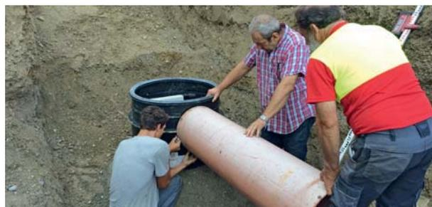
Der Schachtboden ist auf der vorbereiteten Aufstandsfläche entsprechend der Höhe Lage der Anschlussrohre zu positionieren.
