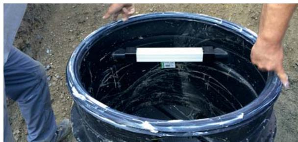
Zur Herstellung der Steckverbindung ist die Elementdichtung am oberen Ende des Schachtbodens bzw. -ringes aufzustecken und auf passgenauen Sitz zu überprüfen.
