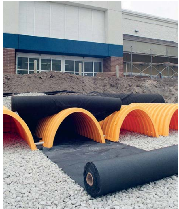
Abbildung 13: Bändchengewebe unter Isolator Row und Umhüllung mit Vliesstoff bei SC-310 & SC-740
