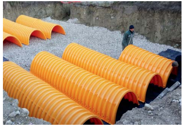
Abbildung 12: Bändchengewebe unter Isolator Row und den Einlassen der benachbarten Tunnelreihen
