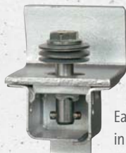
Verschraubung in Zarge
